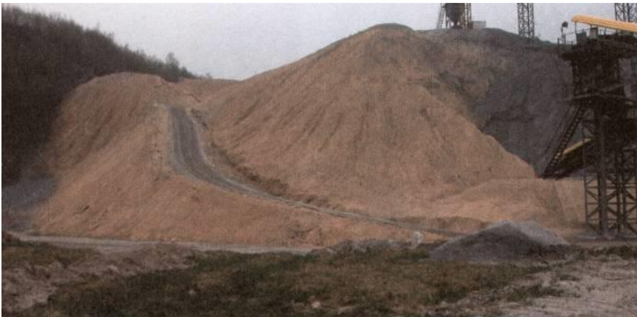
protezione temporanea superficiale (fissativo antipolvere) dei cumuli di ripresa dei materiali
