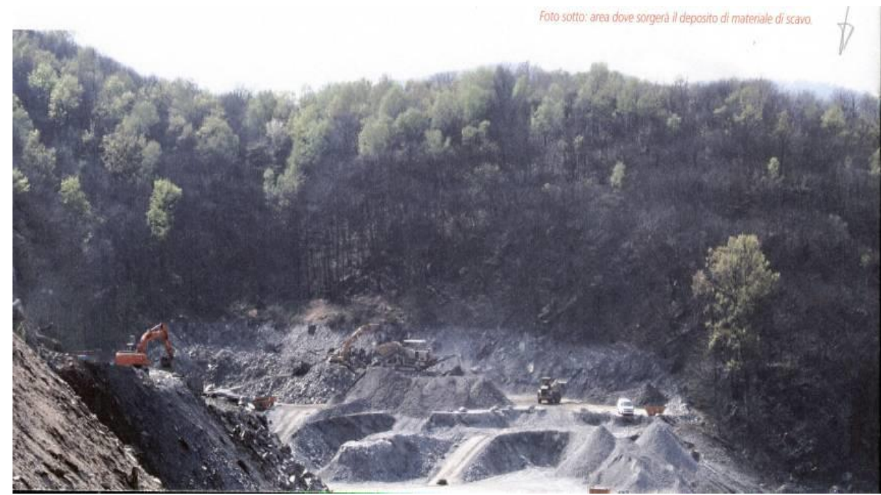
Fasi progettuali e preparazione del sito di discarica di Sigrino
